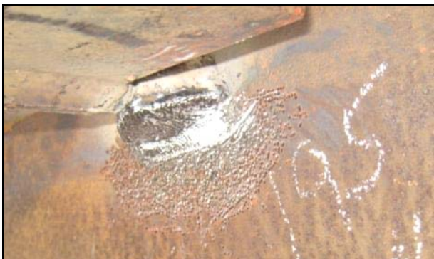
Figure 8. Weld Repaired Detail after UIT
