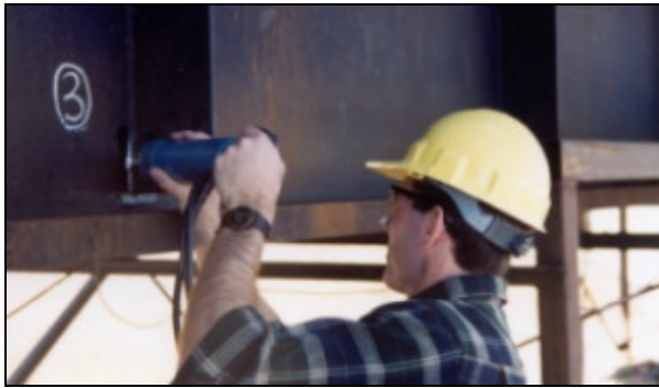
Exhibit 3. UIT in Progress at Stiffener Weld Toe
